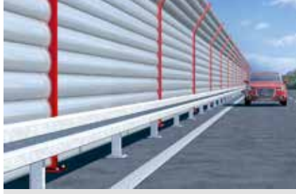
Çarpma bariyerleri ve ses yalıtım duvarları
