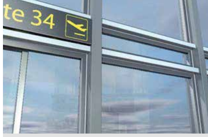
Dış cephe derzleri
